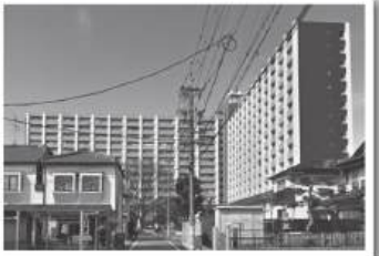
旧西枇杷島庁舎解体後の跡地利用
