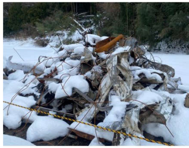
ガードレールと瓦礫
