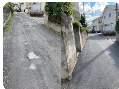
道路整備「舗装工事」
