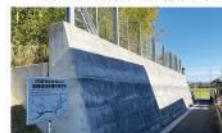
土砂災害防止の擁壁(竹之内)
