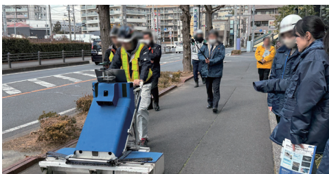
2月12日に実施した空洞化調査に立ち会った際の様子
