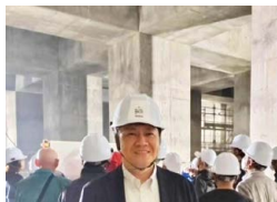
城北中央公園貯水池工事 現場視察
