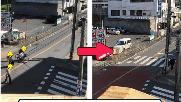
横断歩道を設置し、安全確保
