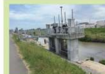
仙石雨水ポンプ場
