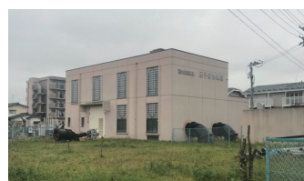
田子排水機場
