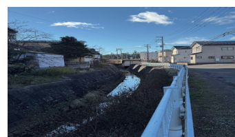
水車堀 【福田町・福住町間】
