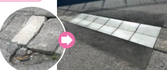
保育園前の側溝整備
