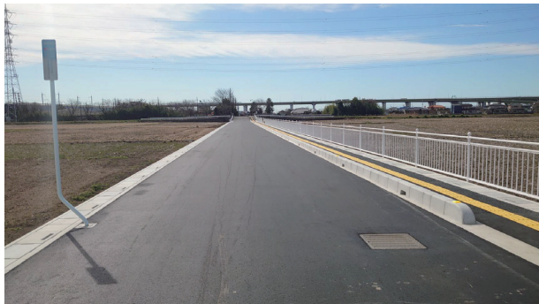
工事完了後の市道久喜215号線(北青柳)
