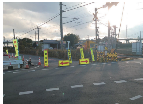
工事中の沙汰踏切南側
