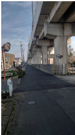
令和6年度補修箇所
