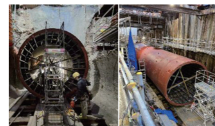
破損した下水道管の代わりに敷設した新しい下水道管(鋼製セグメント)
