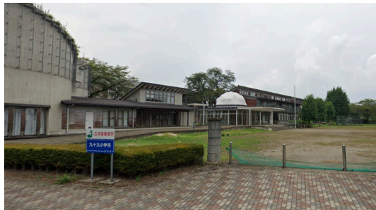
▲今後もプロポーザルを行う旧九十九小学校
