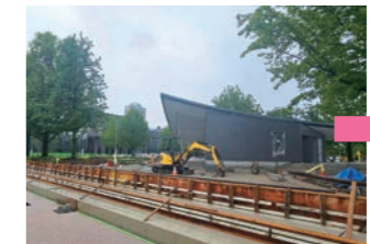
●現在工事中です(6/27撮影)
