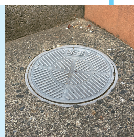
わが家の敷地内に8カ所の排水ますを確認
