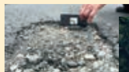
県道市道の 道路改修対応
