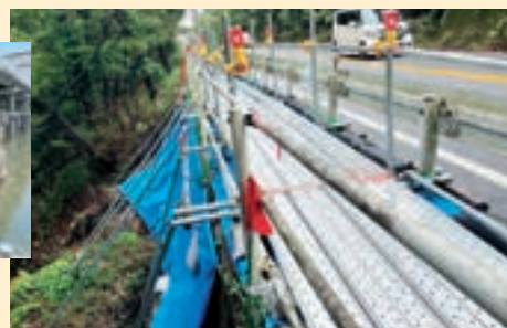
災害対応248号線歩道+法面改修対応
