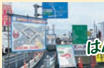
多治見IC改修工事視察
