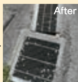
県道16号多治見犬山線：側溝詰り対応
