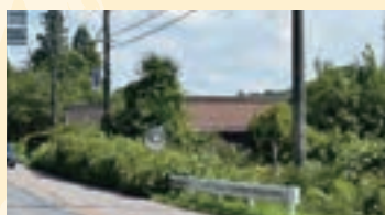
県道113号善師野多治見線：除草対応
