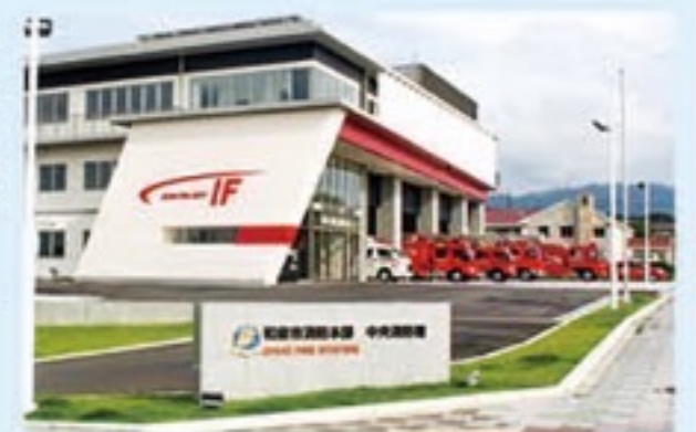
令和2年に完成した「和泉中央消防署」
