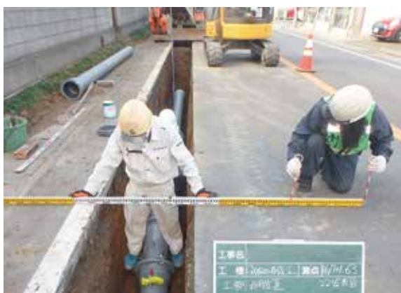
地区で進む上水道の整備
